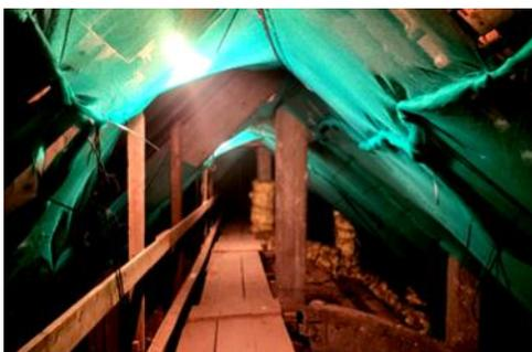
Nach Ostern wurden im Bereich unter den Dachpfannen Sicherungsnetze gespannt. Diese sollen verhindern, dass bei den Sanierungsarbeiten alte Dachpfannen in das Kirchengewölbe fallen. Mittlerweile wurde auch die vom Architekt Wagner ausgewählte Dachpfanne der Firma Nelskamp von der Denkmalschutzbehörde genehmigt. Diese Pfannen werden nun bestellt. Voraussichtlich Anfang der Sommerferien geht es weiter mit dem Aufbau des Gerüsts für die Dacharbeiten.
